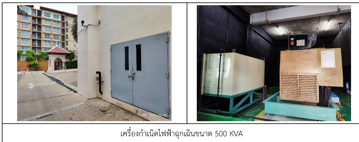
รูปที่ 1-11 เครื่องกำเนิดไฟฟ้าฉุกเฉินของโครงการ
